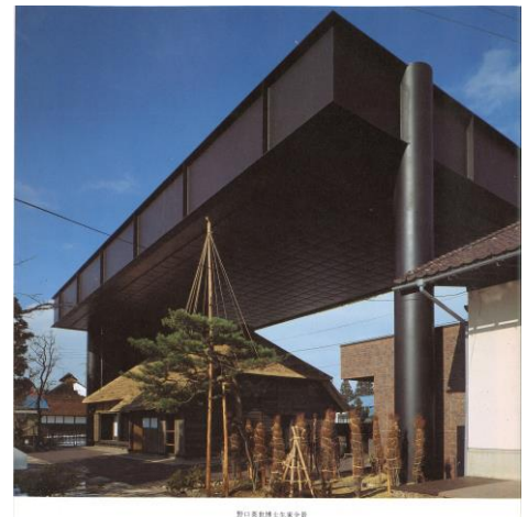
解体復元工事後の生家
