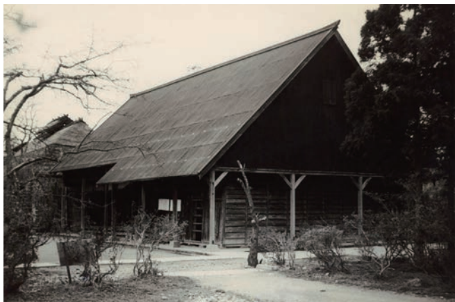
茅葺き屋根をトタン屋根で覆った時の生家
