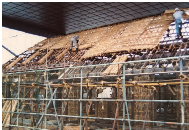
解体修理工事の様子
